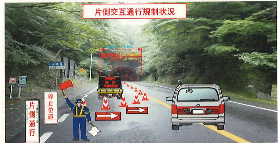
新天城トンネルでの片側交互通行規制
